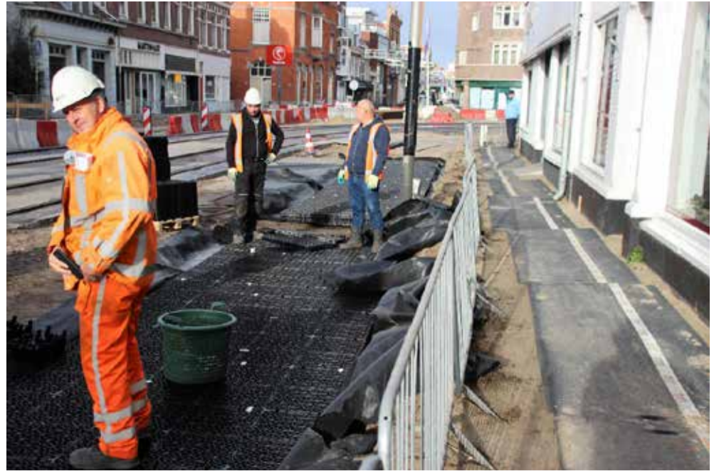
de bomenkratten in aanleg
